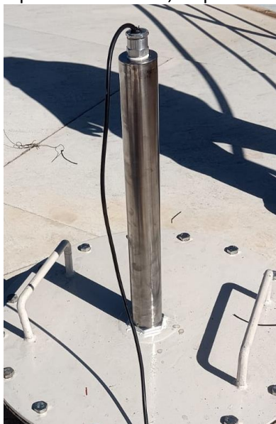
Figura 20 – Finalização da instalação da sonda flexível
