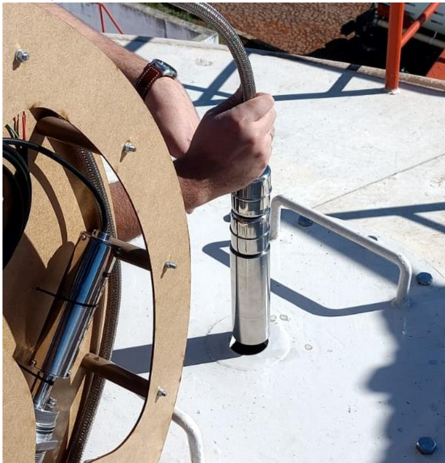
Figura 5 - Iniciando a introdução da sonda no tanque
