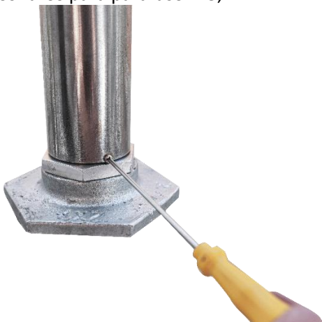
Figura 19 - Aparafusamento da proteção da cabeça da sonda
